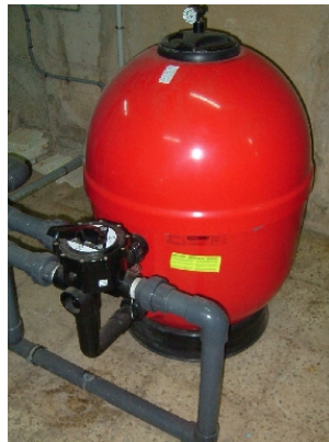
Manòmetre a capçalera d'un filtre
