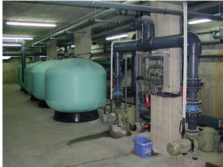
Equips de recirculació i filtració
